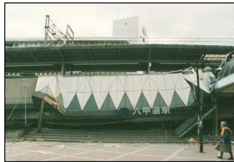
一階部分が潰れたJR六甲道駅
