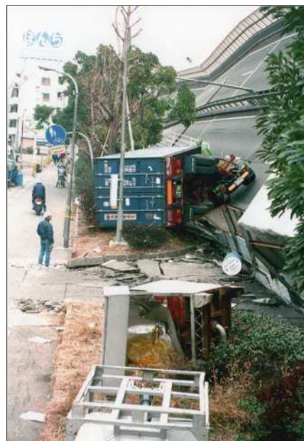
倒れた阪神高速3号神戸線
