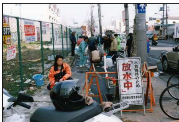
スタンドパイプを用いての配水
