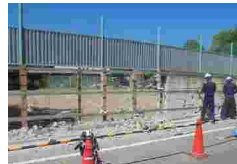
▶中村中学校での撤去作業
