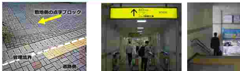
建物敷地と道路の境界で点字ブロックが繋がっていない。案内標示でわからない。
