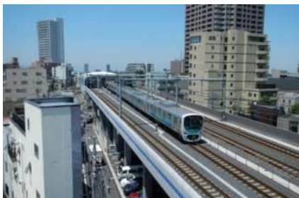
鉄道が立体化された西武池袋線 (石神井公園駅付近)
