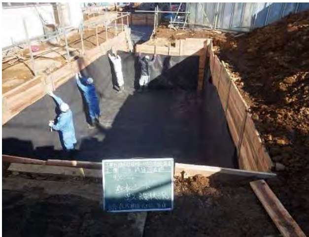
雨水貯留浸透施設
