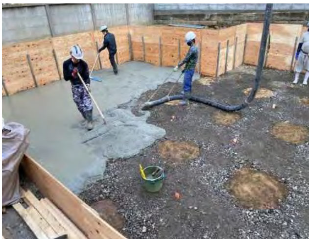
捨てコンクリート打設
