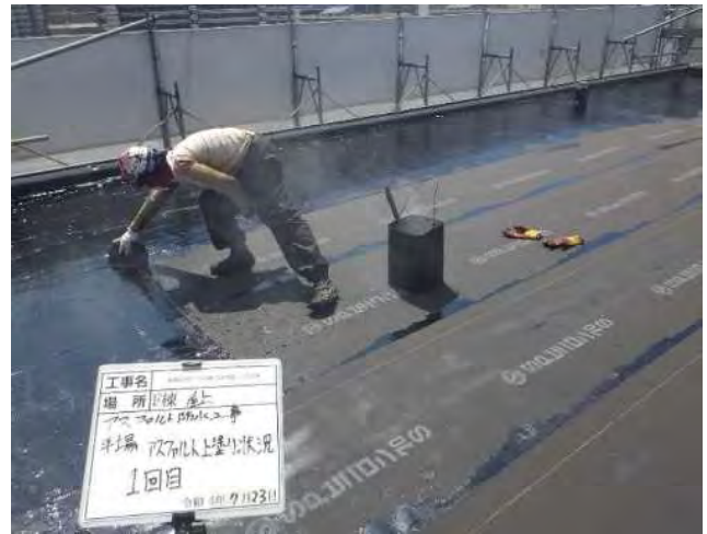
アスファルト防水施工状況
