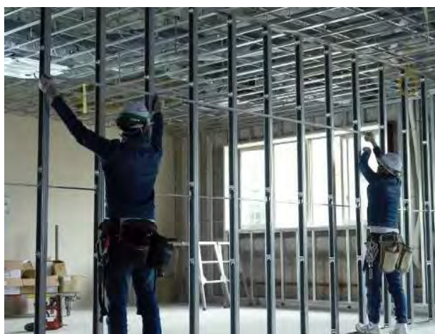
↑ 軽量鉄骨工事
