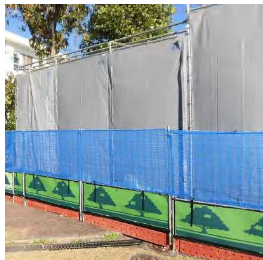
↑ プール解体(防音シート)
