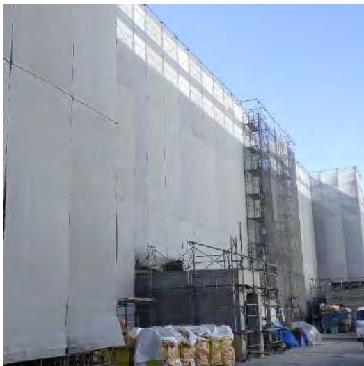
↑ 仮設足場(メッシュシート)
