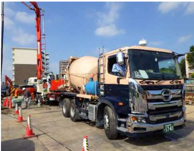
↑ コンクリート打設
