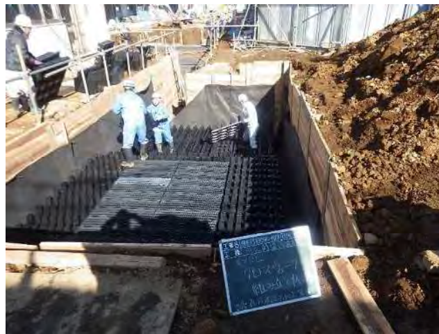
雨水貯留浸透施設
