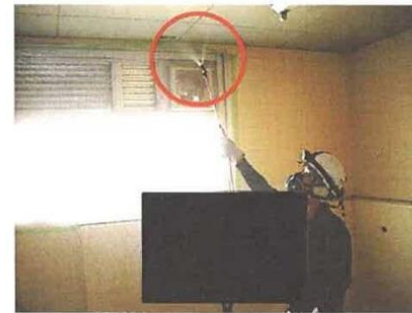
天井材に湿潤材を散布
