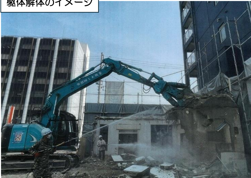
躯体解体のイメージ
