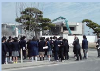
【長瀬小】建て替えのため校舎が取り壊されていました
