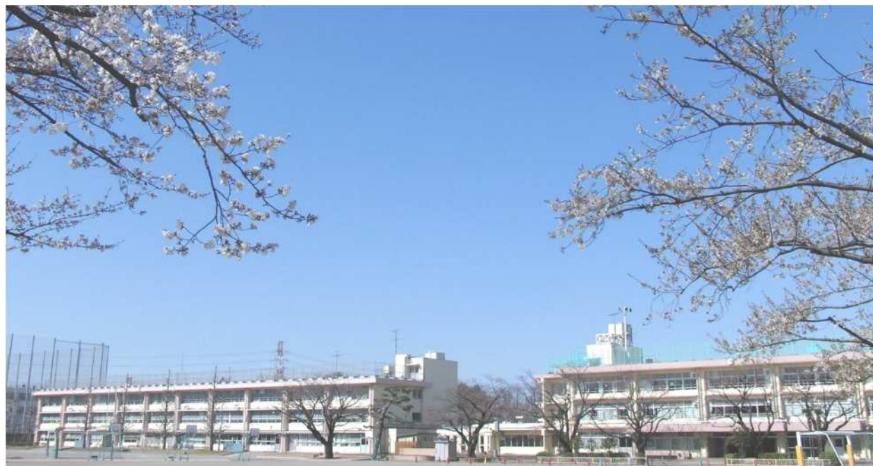
施設一体型小中一貫教育校 大泉桜学園（向かって左は旧中学校校舎、右は旧小学校校舎）
