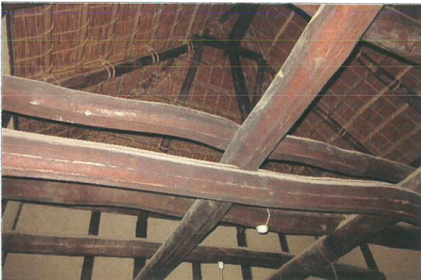
内部の屋根部分
