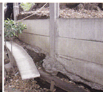
落下した塚崩落防止壁
