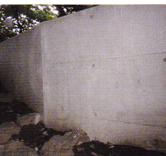
新しくなった塚崩落防止壁
