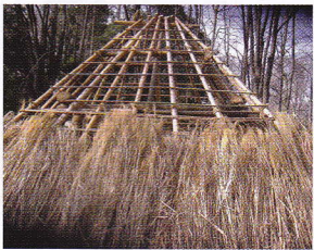
図3 茅葺き替え作業
