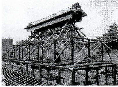
屋根組み (11月8日)
