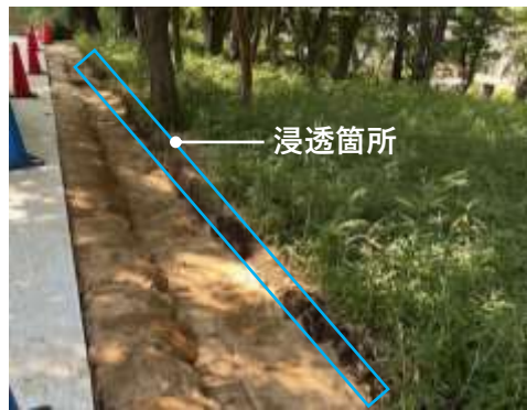
写真2：雨水浸透施設（施工後）
