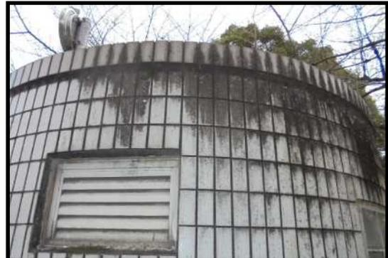
【外壁タイルの汚れとシーリングの劣化】
