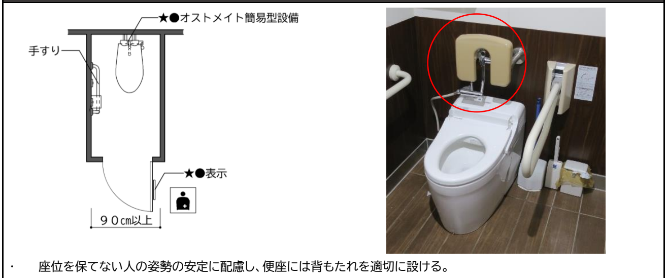
<図 I-8-6 オストメイト簡易型設備を設けた便所の例> (改善・改修等の場合)
