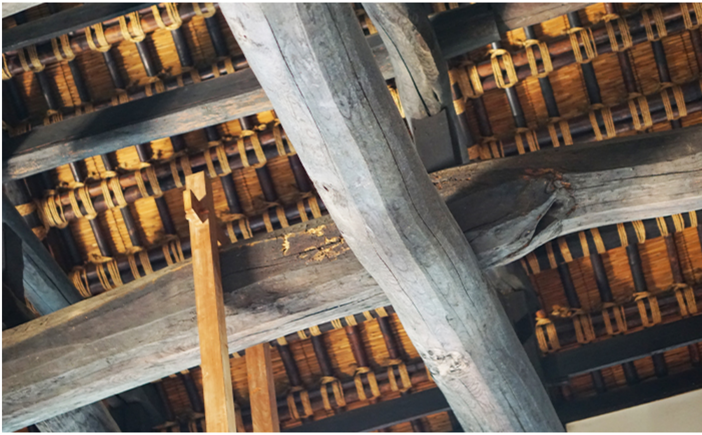
天井は縄で竹を編んで作る、傘（からかさ）造り、大黒柱を中心に、傘と同じ形状で建てられました
