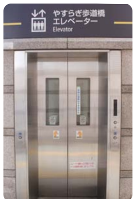
(写真:やすらぎ歩道橋)
