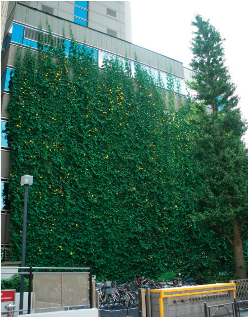
区役所本庁舎のみどりのカーテン (平成22年8月25日撮影)
