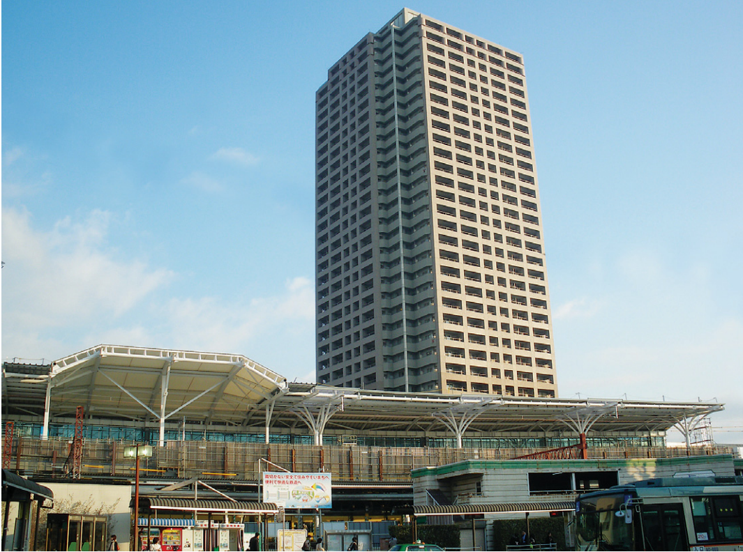
高架化が進む西武池袋線石神井公園駅
