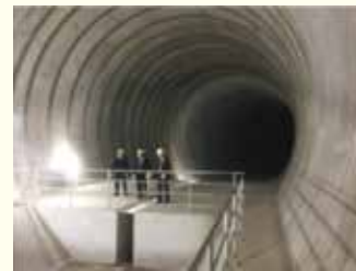
시라코강 지하 조절지(용량: 212,000m 3 ) 구조 형식: 지하 터널식 태풍 19호에 의한 저류율: 약 90%
