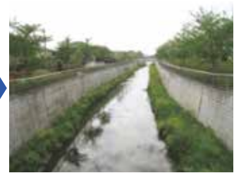
샤쿠지이강(호안 개수 후)
