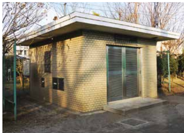
学田公园内的应急水箱的管理设施 (地下设有1,500m³的水箱)
