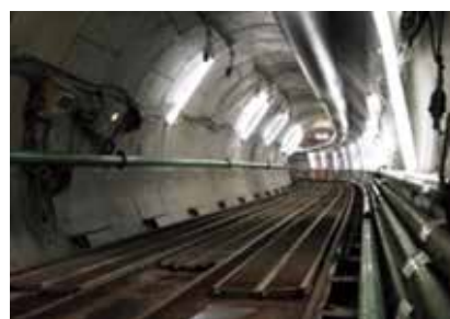
第二田柄川干线（整修中）
